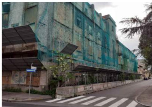
03 - vista da via Luigi Settembrini
