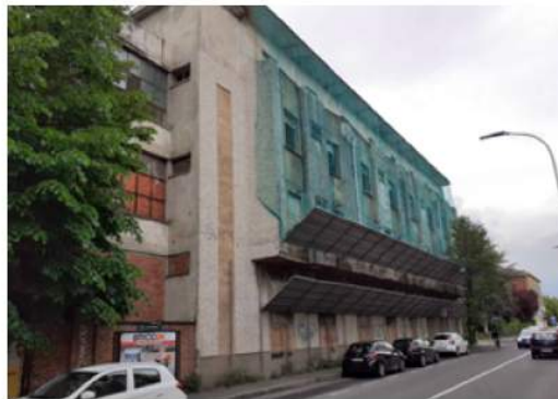
02 - vista edificio in corso di demolizione lungo viale Circonvallazione
