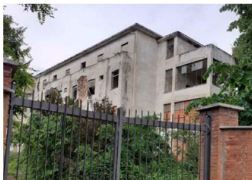
04 - vista della corte interna
