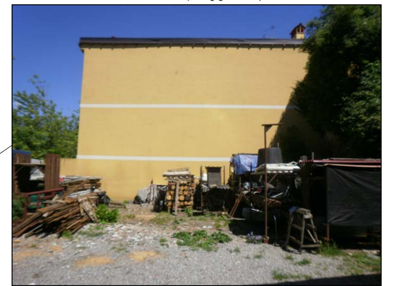
edificio a confine di terzi (mapp. 275), lato est
