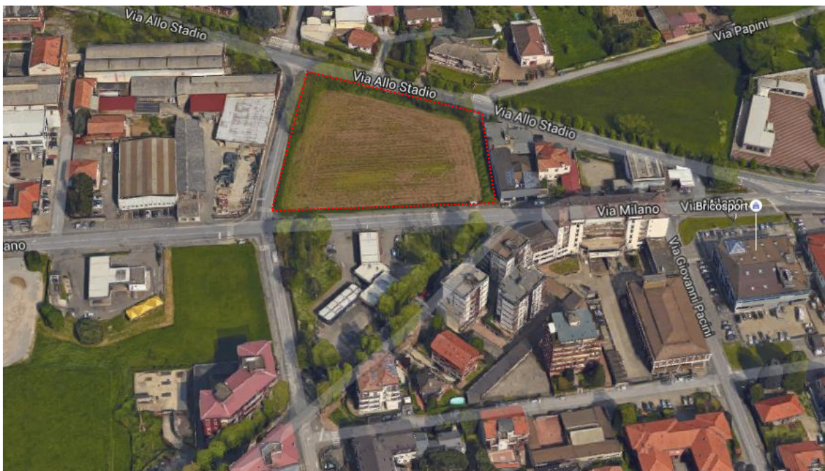
Figura 8 - Vista OVEST dell'ambito oggetto di intervento (foto aerea)
