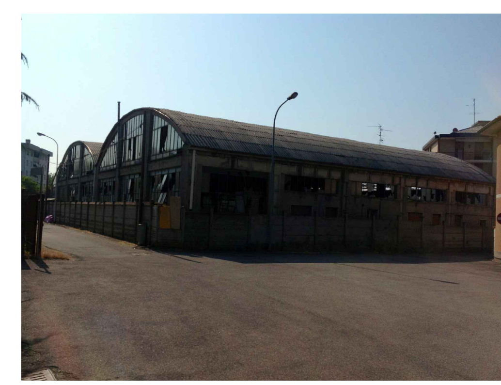
F6 - Vista angolo Via Dell'Oca, Via La Malfa
