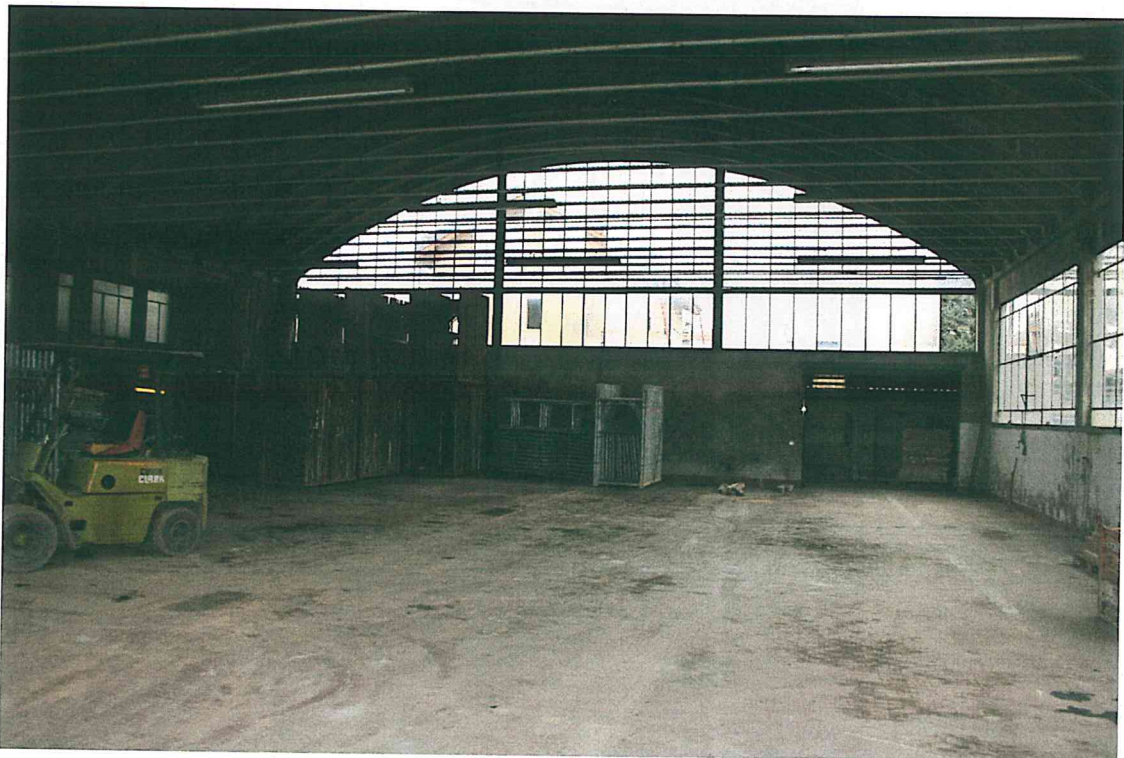
Foto 4 – Panoramica interna capannone al mappale 47
